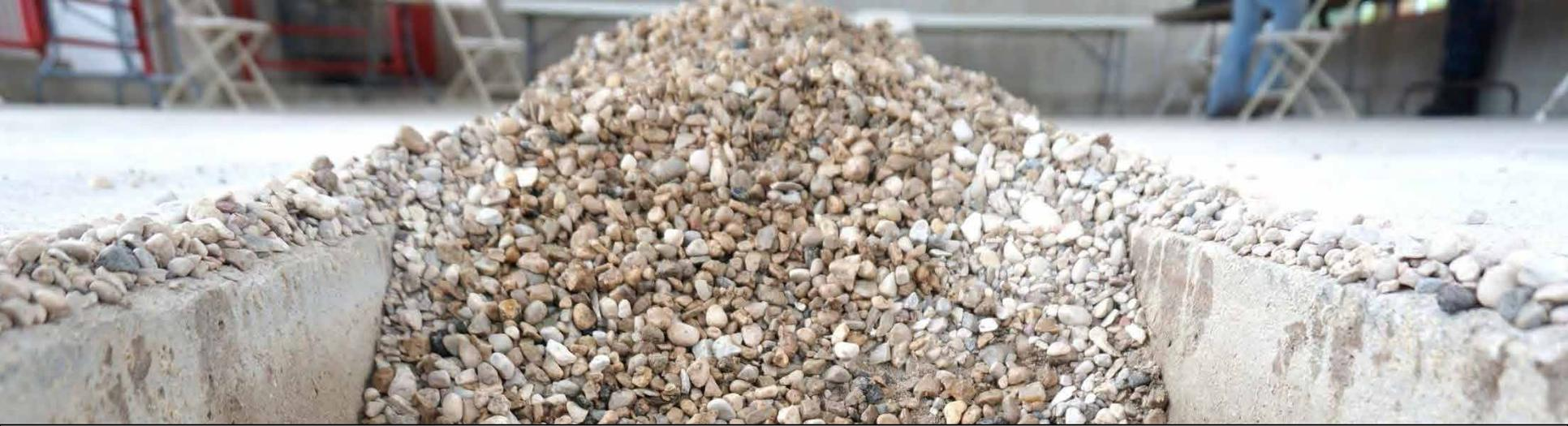
Abfluss-System mit 25 cm Kiesel­schicht und Drainageschlauch
